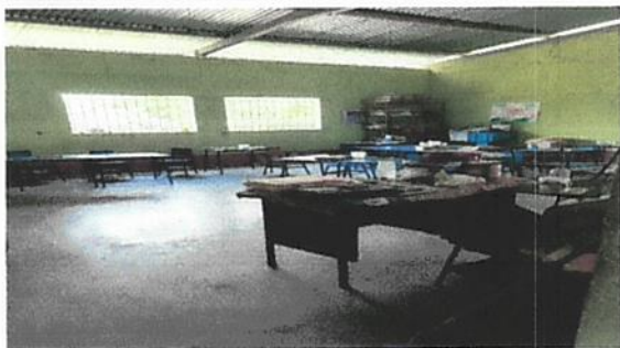
Foto 5: interior del Aula 2, se sustituirá el piso de cemento por cerámico, se repellarán y pintarán los muros, se instalarán ventanas de PVC con vidrio y se suministrará cableado eléctrico.
