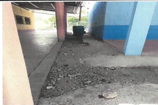
Foto 6: Instalación de banqueta de concreto a lo largo del corredor.
