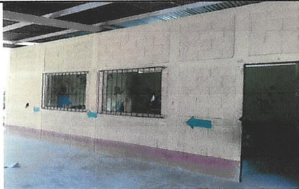
Foto 2: Aula 1 a intervenir: se renovará la pintura de los muros exteriores y se instalarán ventanas de PVC con vidrio.
