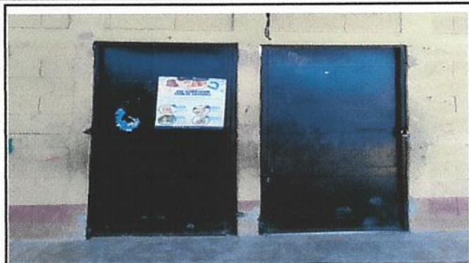
Foto 1: Las puertas que se intervendrán: se lijarán, y pintarán. Además, se reforzarán los marcos y se instalarán chapas.
